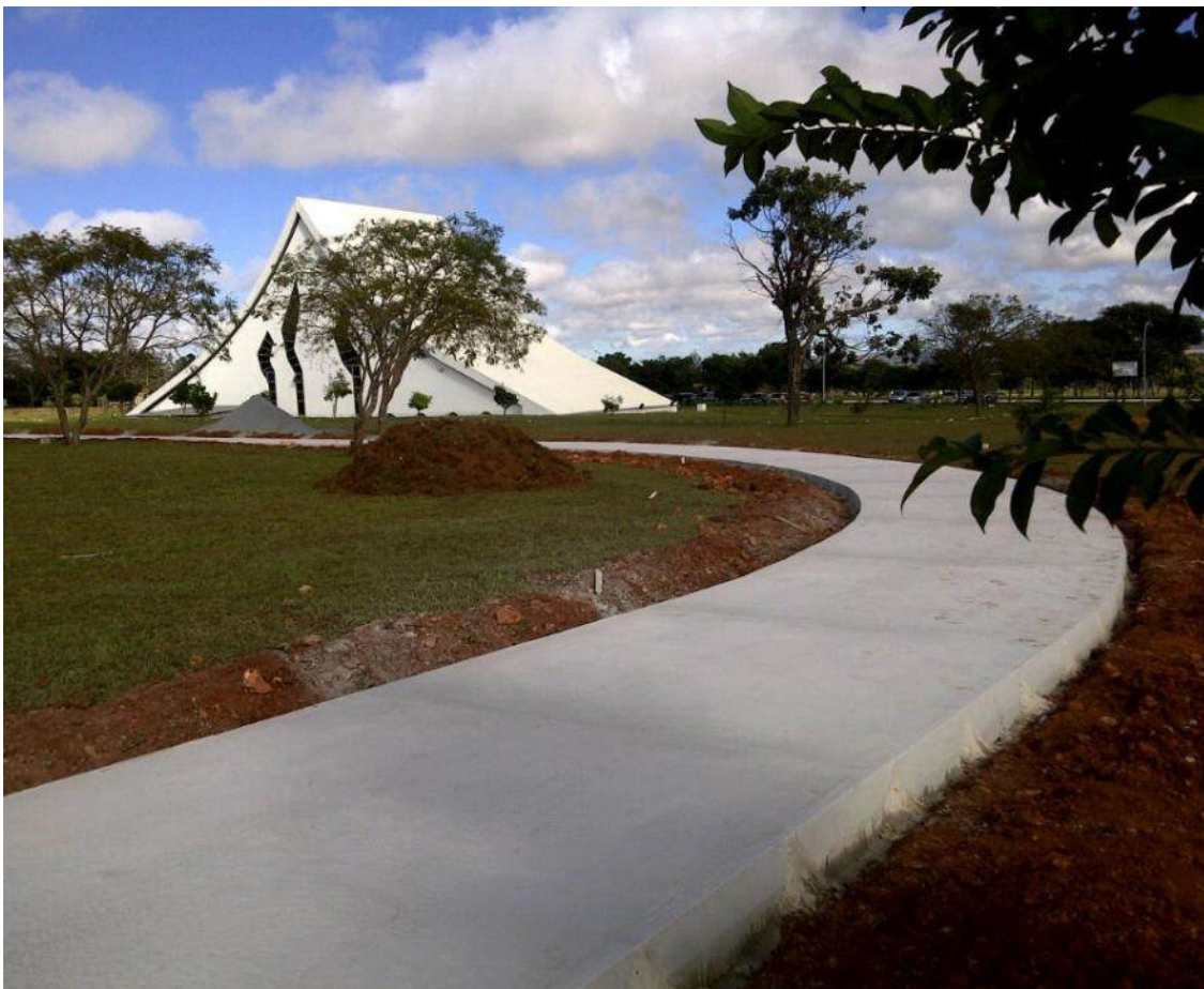
Ciclovía no Eixo Monumental em fase de pavimentação (fonte: ABCP)
